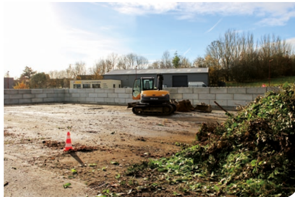
Le mur en blocs béton clôturant la plateforme déchets verts à la déchèterie de Montbizot
